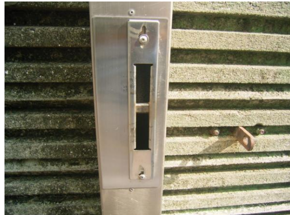
(実施写真) 手洗い洗浄器取付金具 (全学教育棟身障便所) 門受口金具 (田中記念館出入口)
