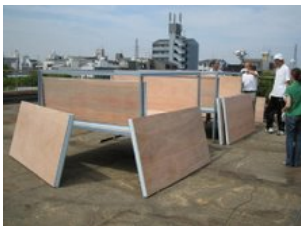
写真 3 組立中の L 型鋼と断熱パネル
